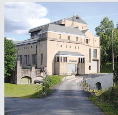
ГЭС «Hakavik» расположена на озере Эйкерен в провинции Бускеруд. Она была сдана в эксплуатацию в 1922 г. ГЭС оснащена четырьмя ковшовыми гидроагрегатами мощностью 2,3 МВт.
