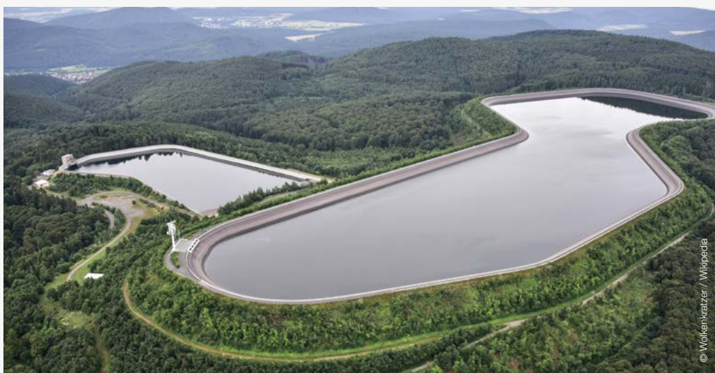
В 2017 г. «Uniper Kraftwerke GmbH» (Германия) установила системы на ГАЭС «Waldeck 1» (одна насос-турбина мощностью 70 МВт) и «Waldeck 2» (два трехкомпонентных гидроагрегата мощностью 240 МВт каждый)
