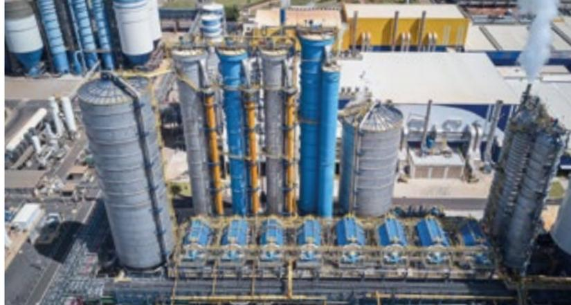
新的阔叶木浆线能够确保低运行成本、低排放、极高的洗浆效率和出色的纤维品质。产能(6,120吨/天)为世界单条浆线最大。
