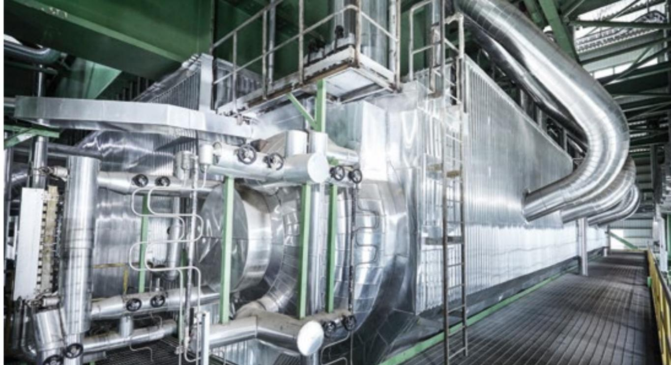
OKI碱炉的汽包是目前全世界在运行的最大的汽包。汽包重达270吨,长度23m。
