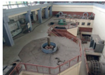
▲ WKW Djoué vor der Sanierung
