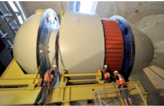
▲ Generator während der Montage in WKW Iffezheim
