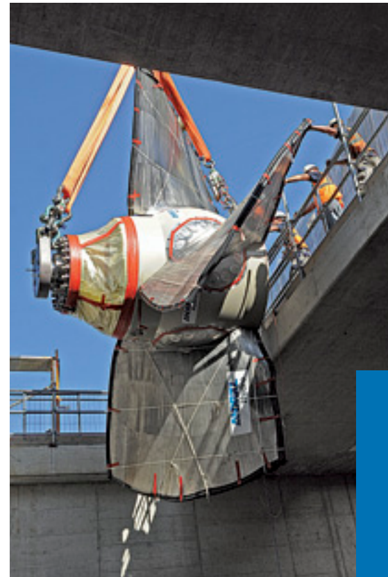
▲ Das Turbinenlaufrad während der Montage in WKW Iffezheim
