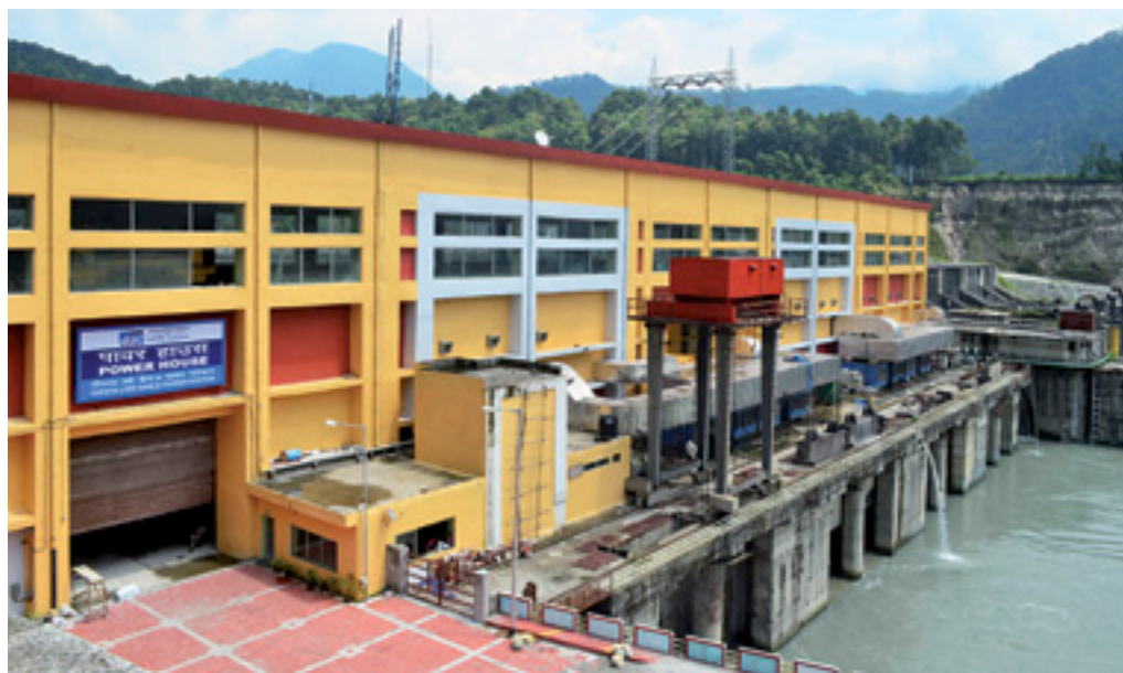
▲ Blick auf das WKW Teesta Low Dam III
