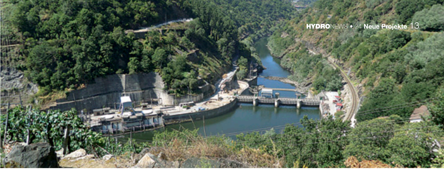
▲ Blick auf die Baustelle San Pedro II
