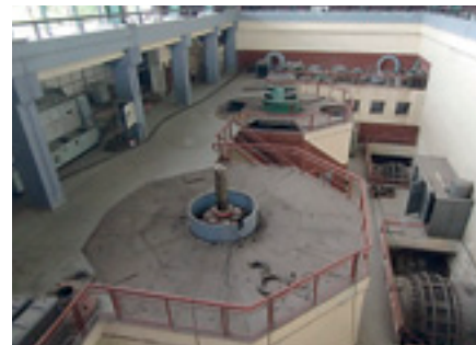
▲ CH Djoué antes de la rehabilitación
