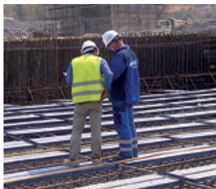
▼ Trabajos de fundación
