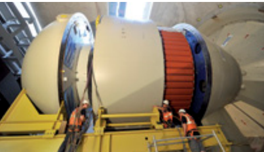
▲ Montaje del generador
