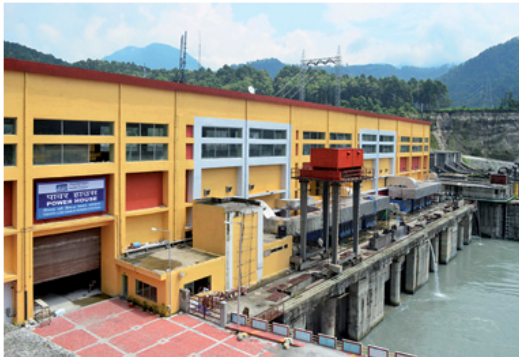
▲ Casa de máquinas de la CH Teesta Low Dam III
