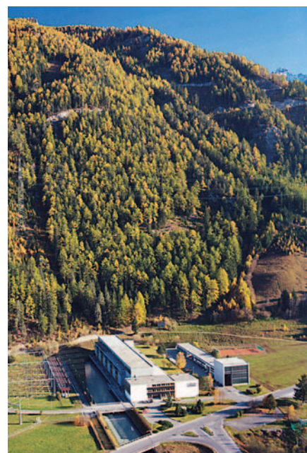
▣ Le bâtiment de la centrale et le disjoncteur
