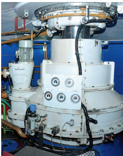
▣ Le puits de la turbine après rénovation
