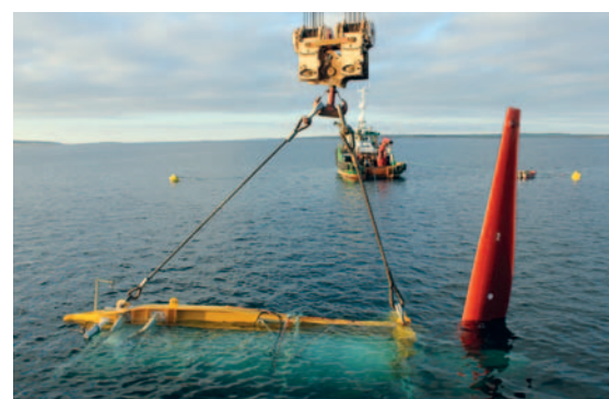
Installation de HS1000 à EMEC
