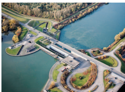
▣ Vue aérienne de la centrale hydroélectrique
