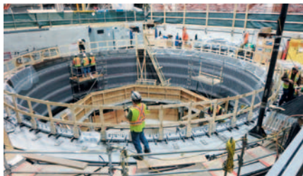
▣ Assemblage du stator
