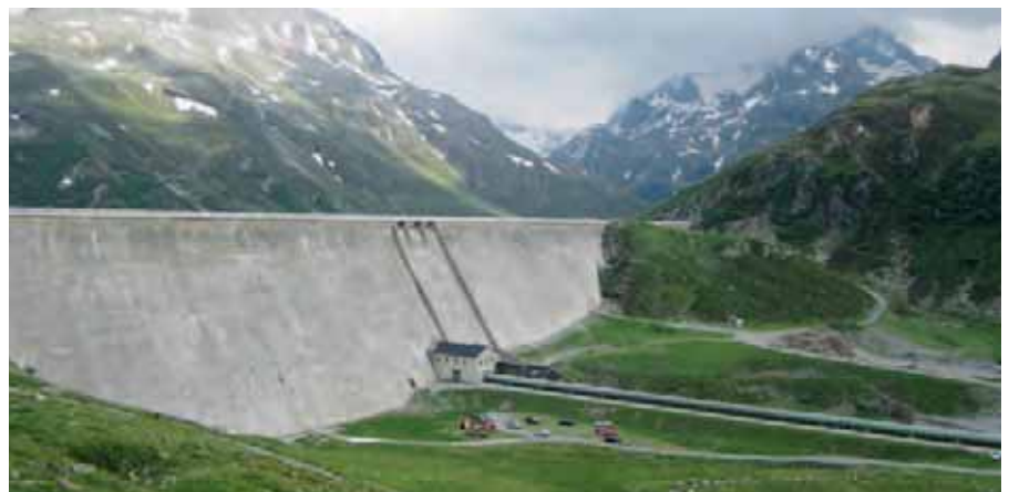
▣ Silvretta barrage for HPP Obervermuntwerk II
