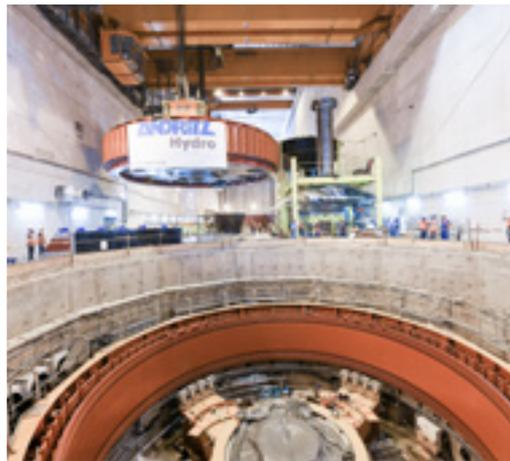
Die Installation des Generatorrotors erfordert absolute Präzision und umfangreiches Know-how.
