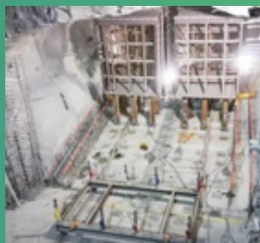
Für Yusufeli werden etwa 2.200 Tonnen Stahl für die Schütze und ca. 3.800 Tonnen Stahl für die Druckrohrleitungen verarbeitet.
