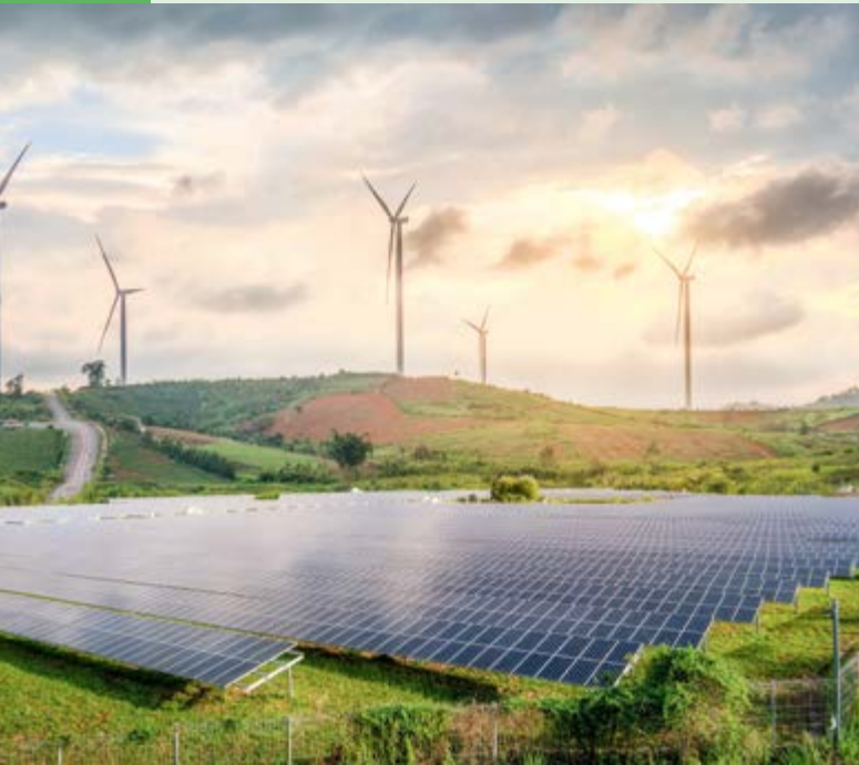
Die verstärkte Nutzung von volatilen Energiequellen wie Wind und Sonne bedarf der ausgleichenden Eigenschaften von Wasserkraft.
