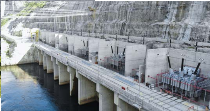
Laúca erhöht nicht nur die Stromverfügbarkeit, sondern bildet auch das Rückgrat der modernen Netzregelung in Angola.
